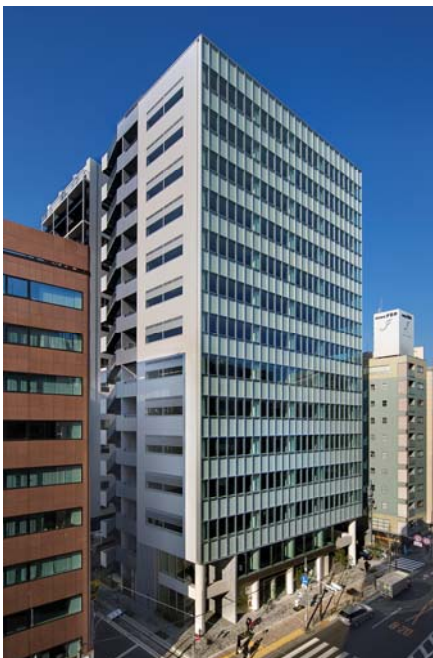
千代田小川町クロス外観写真
